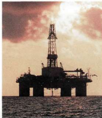
Буровая платформа на нефтяном месторождении в море.
