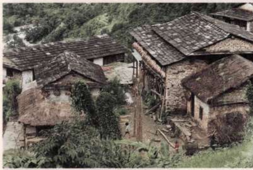
Дома гурунгов сложены из натурального камня без связующего раствора. Крыши — тоже из каменных плит. Непал, Гималаи.
