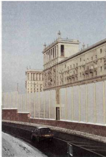
Шумопоглощающие стенки вдоль оживлённой автомагистрали.
