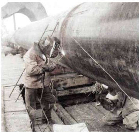
Строительство газопровода в Ямало-Ненецком автономном округе.
