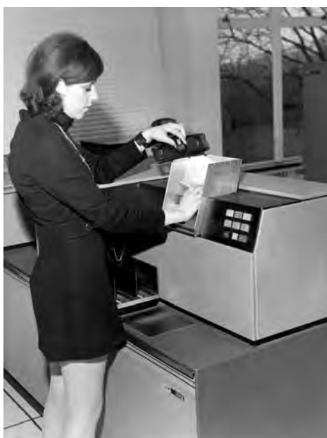
Загрузка колоды перфокарт для работы ЭВМ в пакетном режиме.
